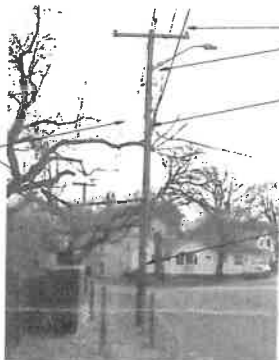
EXISTING CONDITIONS PHOTO DETAIL SCALE: N.T.S.
